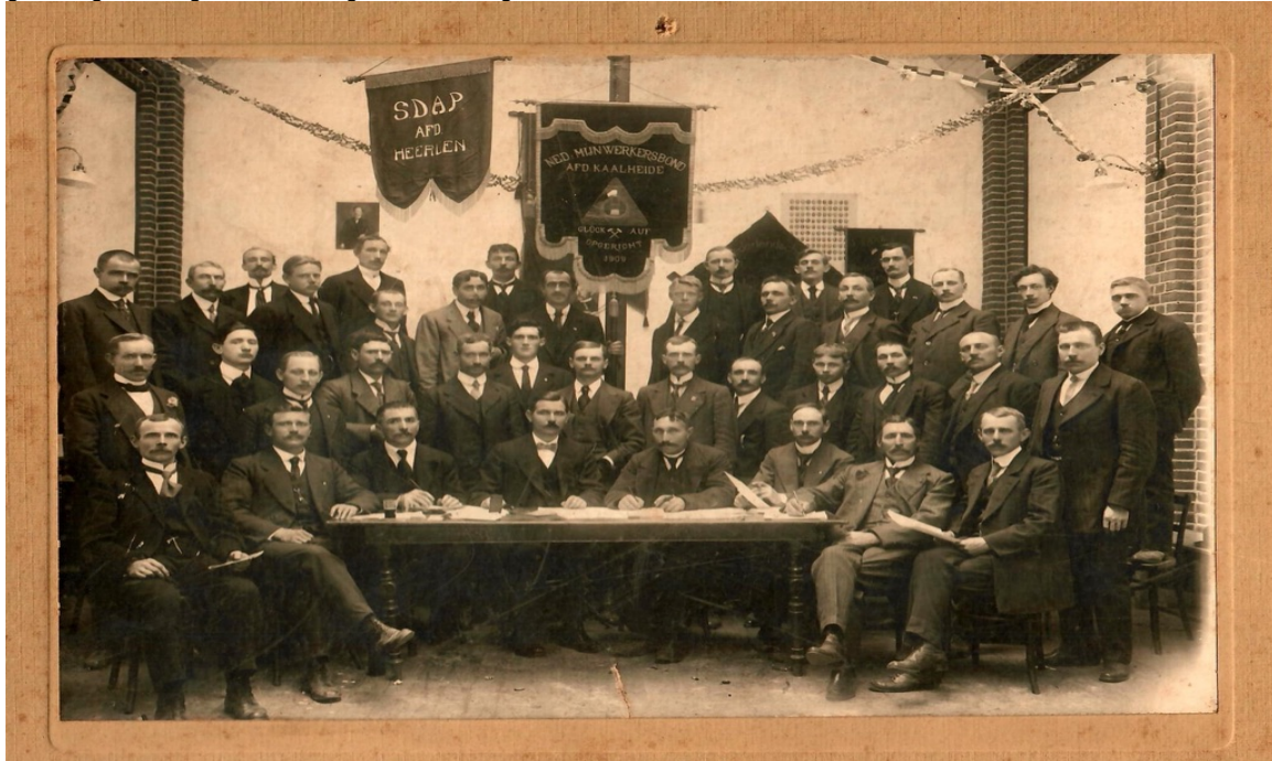
Het middelste vaandel is van de Algemeene Nederlandsche Mijnwerkersbond Afdeling Kaalheide.
